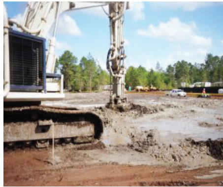
Los taladros grandes inyectan y mezclan el agente aglutinante con el suelo contaminado.
