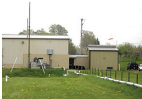
Edificio para el tratamiento de aguas subterráneas
