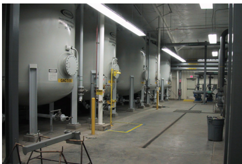
Instalación de tratamiento interior
