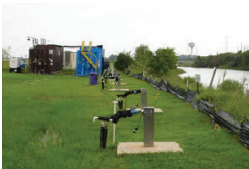
Pozos de bombeo de aguas subterráneas
