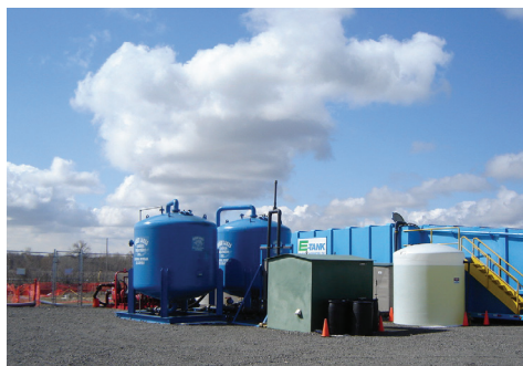
Instalación de tratamiento exterior
