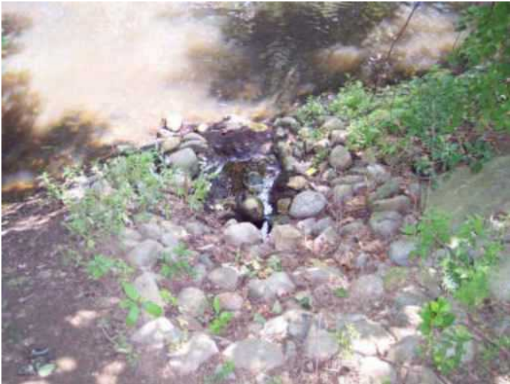
Grace Photo 13: Effluent Water Discharge
