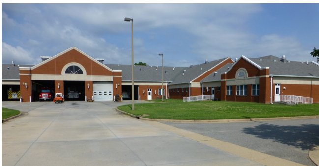
Figure 27. Abex Corp. site (Virginia).
