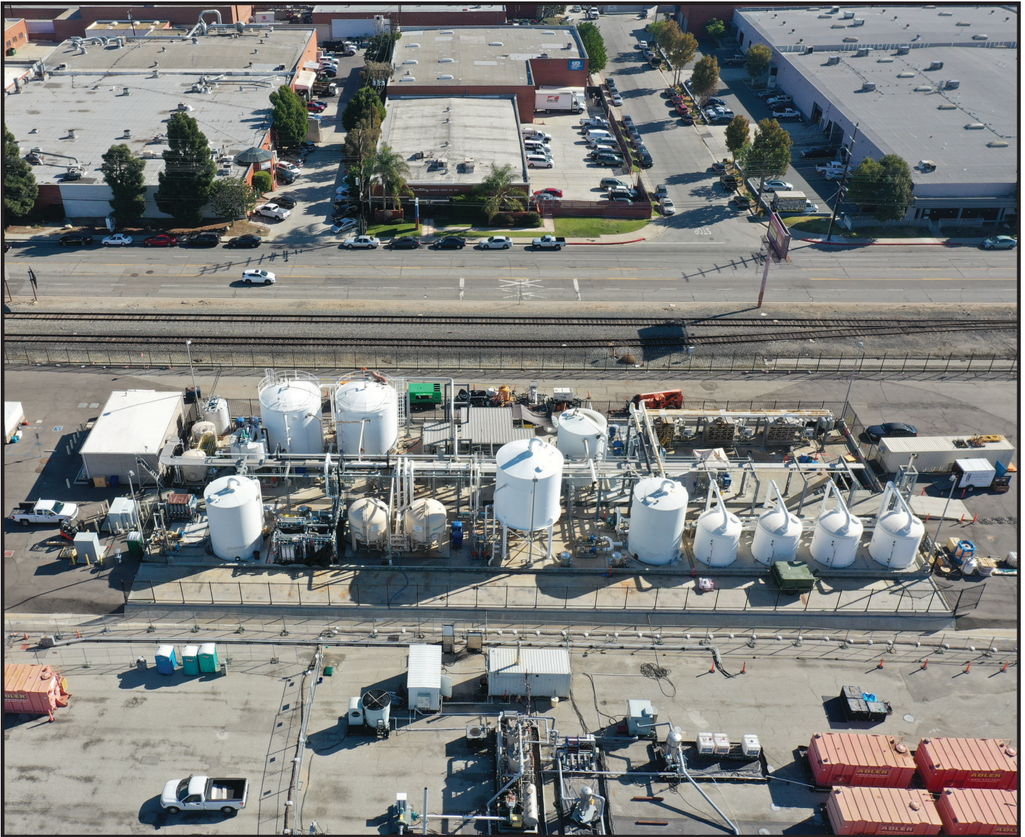
Vista aérea del sistema de bombeo y tratamiento en OU3G: Sitio Dual de agua subterráneas.
