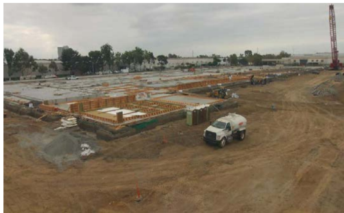
Foto 2: Aquí puede ver cómo se preparan los cimientos para la nueva estructura.
