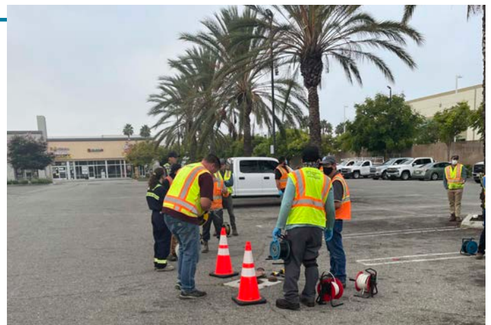
Foto 5: Vista del pozo de extracción de vapores del suelo recién instalado.
