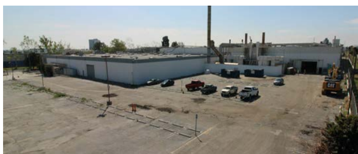
Foto 3: Esta foto muestra el antiguo edificio en el lugar.
