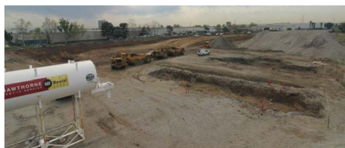
Foto 1: Muestra las iniciativas de excavación y nivelación del suelo que se llevaron a cabo a principios de este año.
