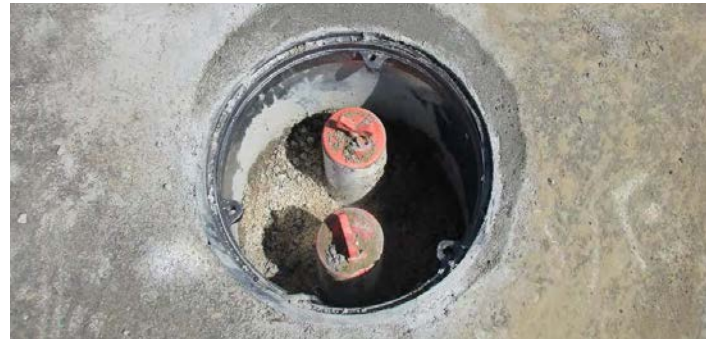
Foto 5: Vista del pozo de extracción de vapores del suelo recién instalado.
