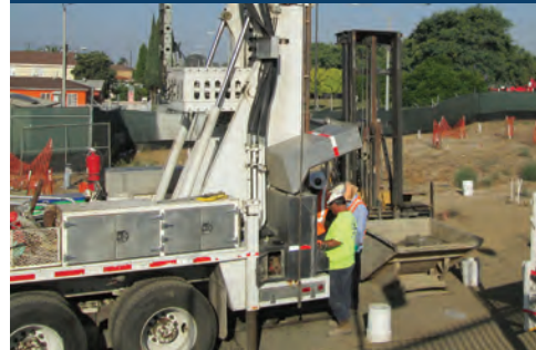
September 2014 removal of heater wells used for treatment. Septiembre 2014 eliminación de pozos calentadores utilizados para el tratamiento.
