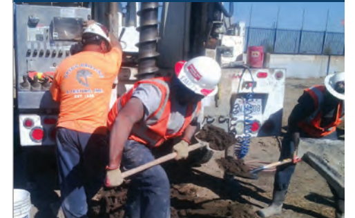
Perforación de pozos abandonado, septiembre de 2014. September 2014 well abandonment drilling.
