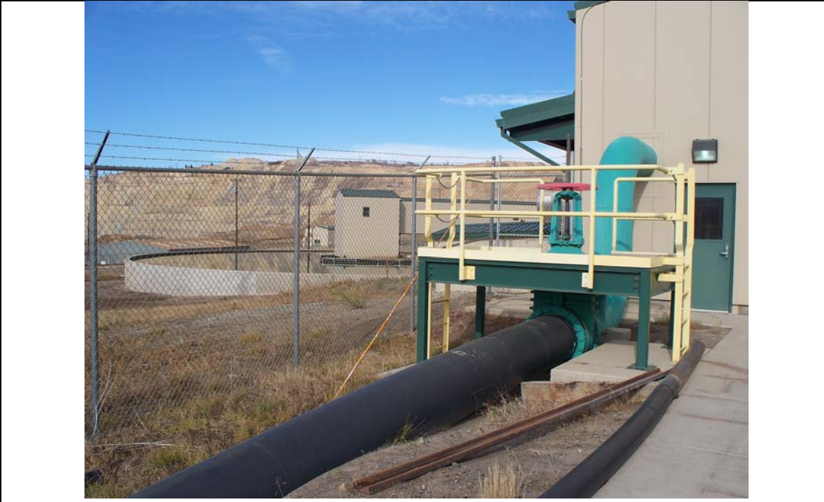
Photo 1. Horseshoe Bend WTP effluent discharge pipeline
