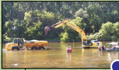
SMA 1-5 - Sediment capping
