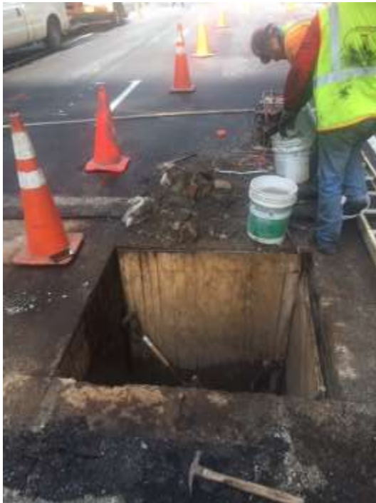
Excavation #2 – Hand Dig
