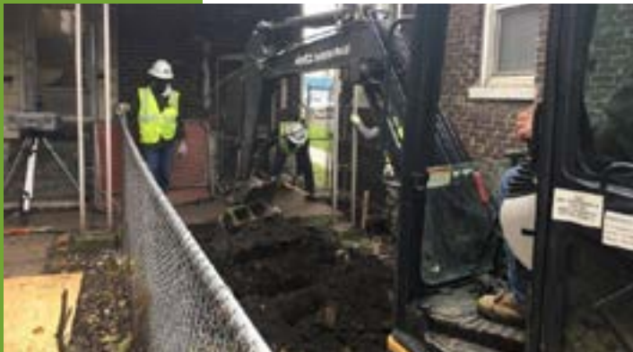
El suelo contaminado es excavado y removido del patio.
