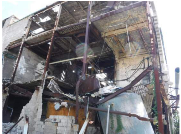
Obiekt przeznaczony do rozbiórki
