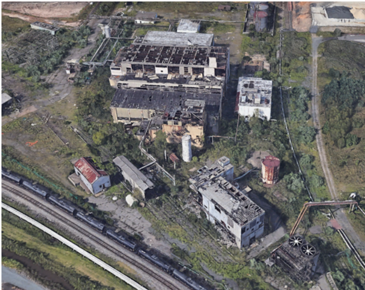
Widok z góry dawnego zakładu LCP Chemicals
