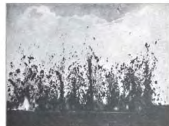
FIG. 18—(18) FOOT DITCH BLAST, ELK GROVE, SACRAMENTO CO., CALIF.
