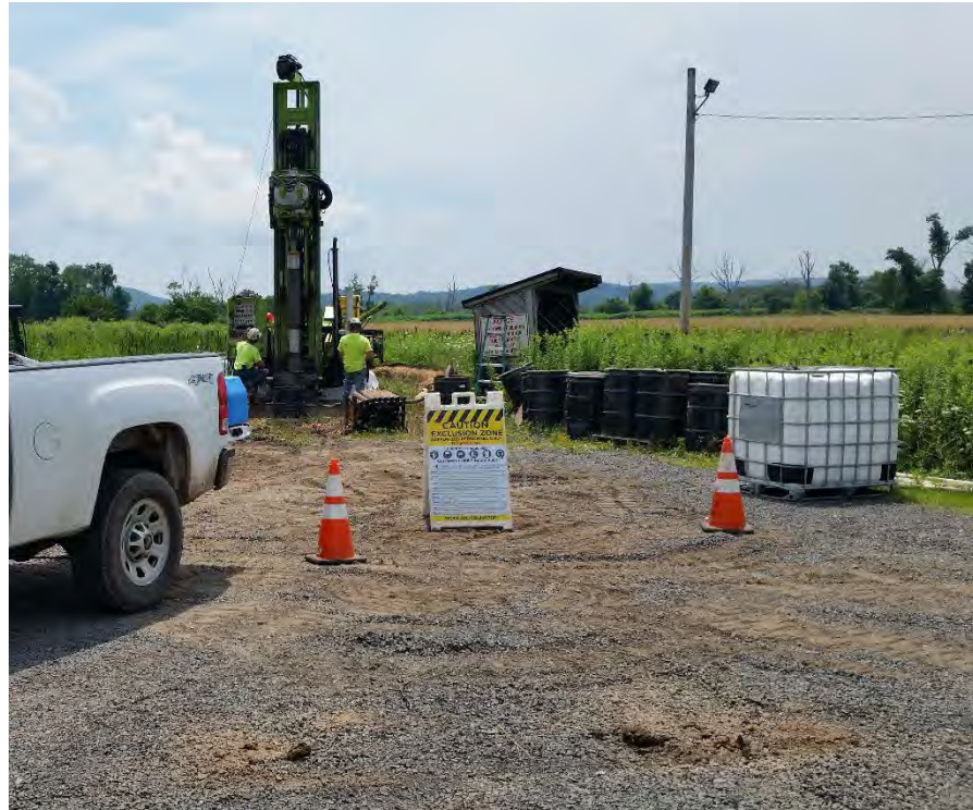
Overburden Drilling - MW-6.
