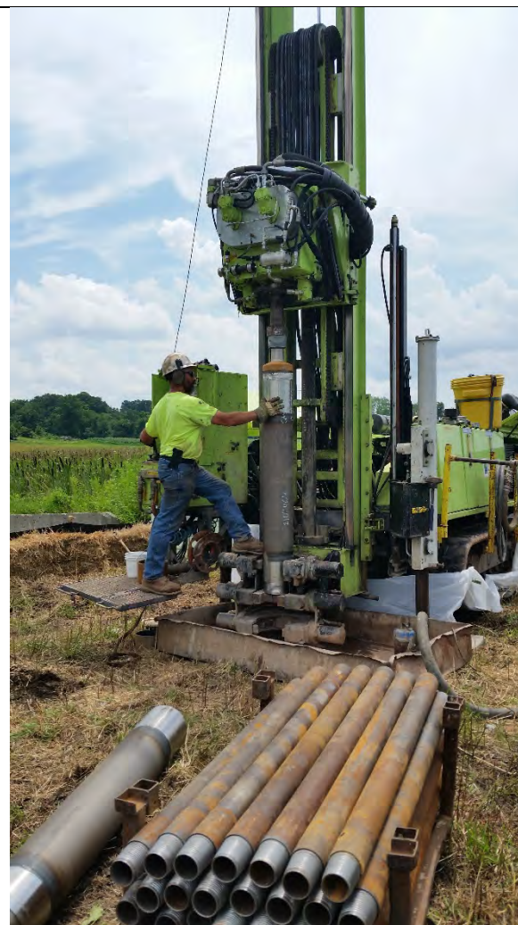
Overburden drilling – MW-6.
