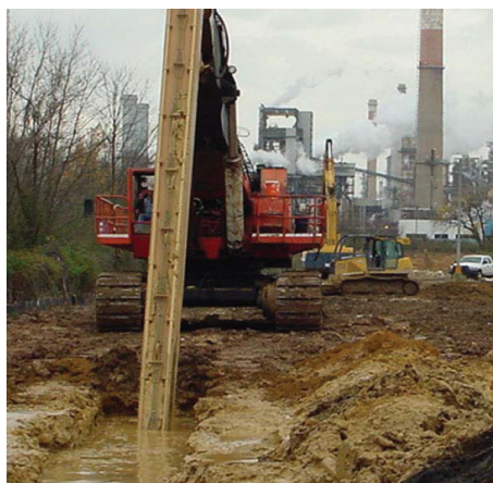
Excavación de una zanja para una pared de lechada.
