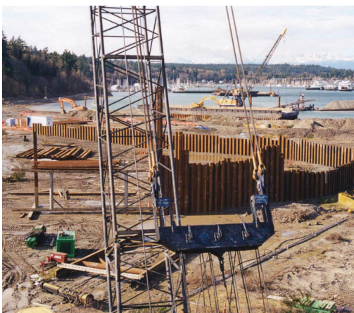
Instalación de tablaestacas.
