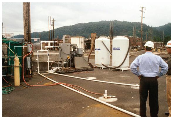
*El sistema de tratamiento en la superficie incluye dos tanques de carbón activado.*
