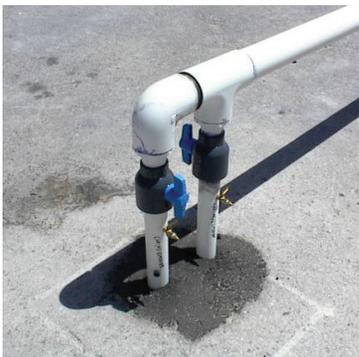
*Los vapores se transportan por tubería del pozo de extracción de la SVE bajo tierra para ser tratados.*
