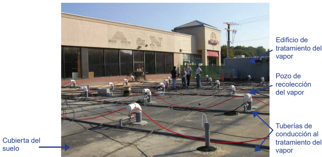
Con el sistema de ERH se limpia el suelo y las aguas subterráneas contaminados.
