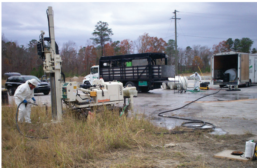
Inyección de un agente reductor en una perforación bajo tierra.
