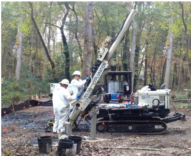
Inyección de enmiendas bajo tierra a través de tubería colocada en un ángulo.
