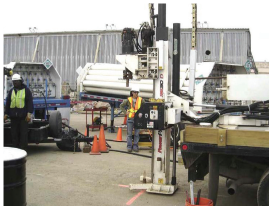
Fracturación neumática en el sitio Superfund Astillero Naval de Hunters Point.
