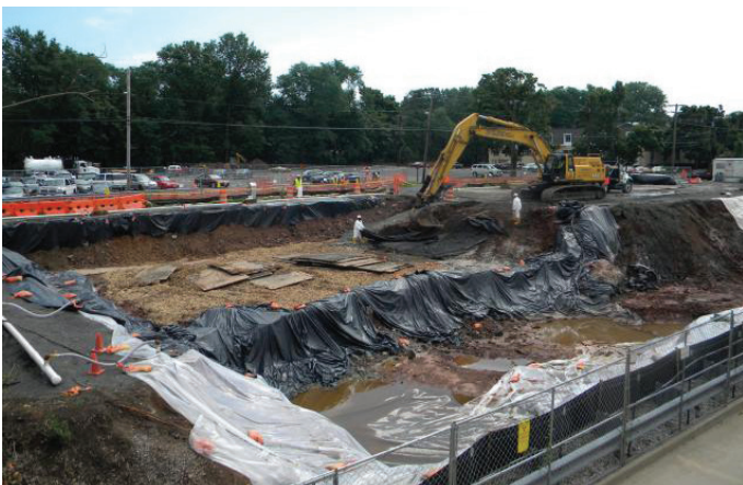
Durante la excavación, las pilas de suelo se cubren con lonas de plástico.
