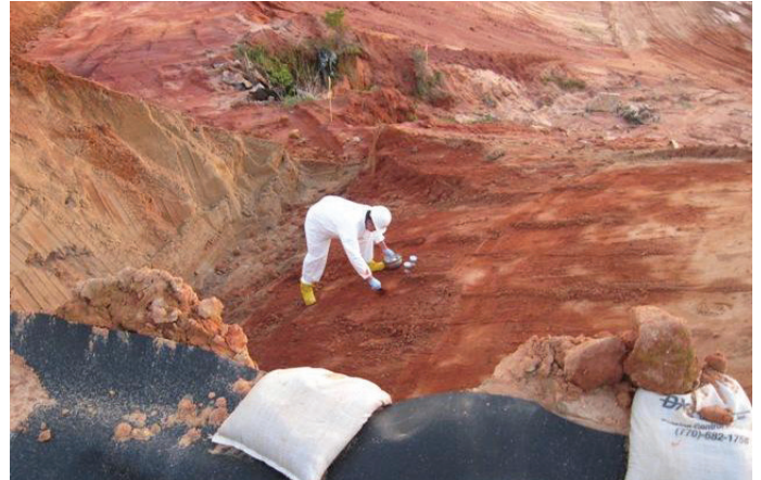
Los obreros toman muestras de suelo para confirmar que el suelo que se deja en el sitio esté limpio.
