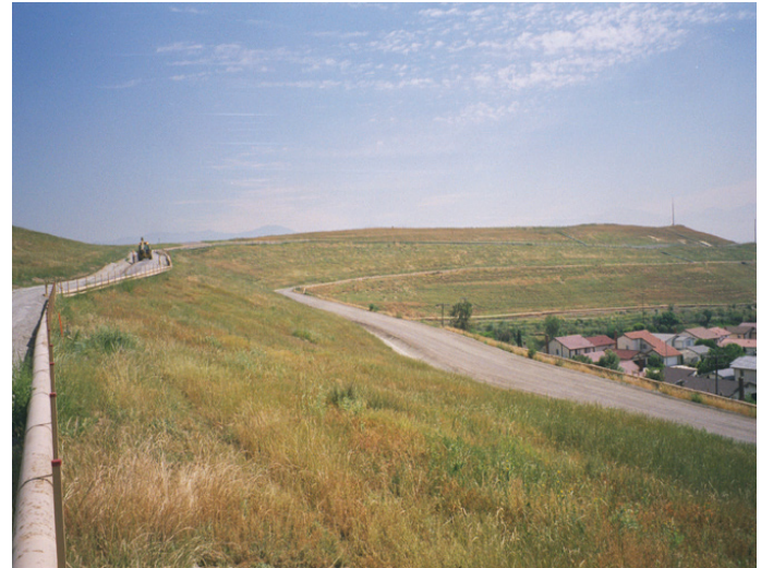
Ejemplo de cubierta de ET utilizada en el sitio Superfund Operating Industries, Inc. Landfill.
