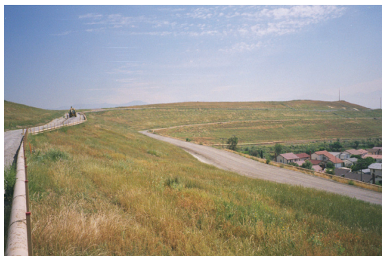
Los pastos de primavera crecen en la cobertura de un vertedero de desechos peligrosos.
