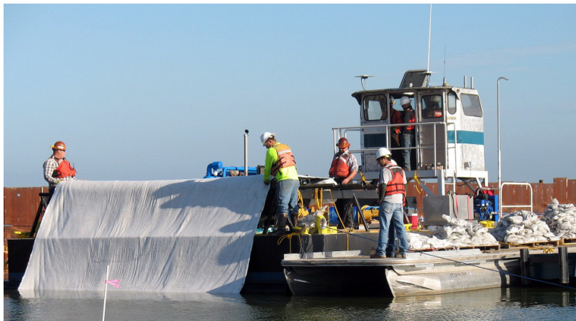
Colocación de una malla de enmiendas que contiene organoarcilla.
