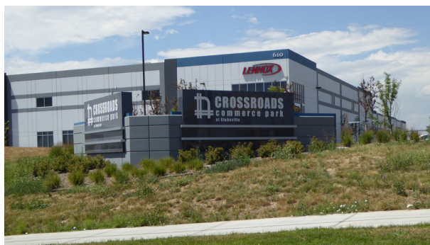
Figure 23. Asarco, Inc. (Globe Plant) (Colorado).
