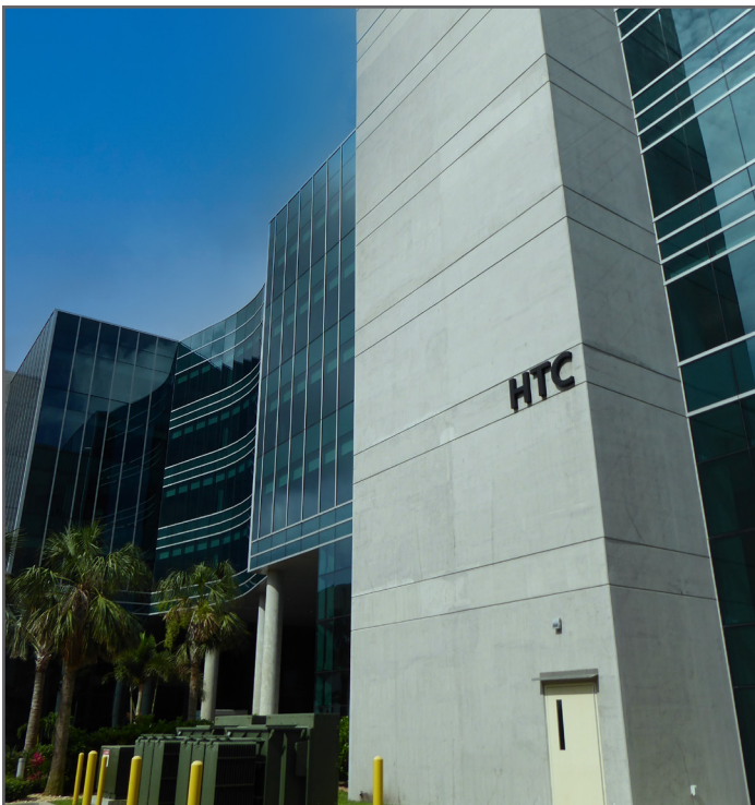
Harris Technology Center en el sitio Superfondo de Harris Corp. (Palm Bay Plant) en Palm Bay, Florida.
