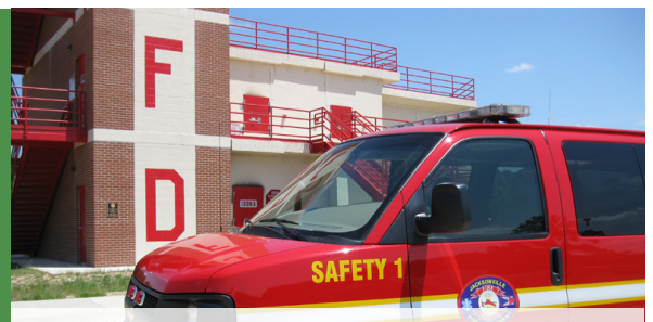
Figure 16: Vertac, Inc. site (Arkansas)
