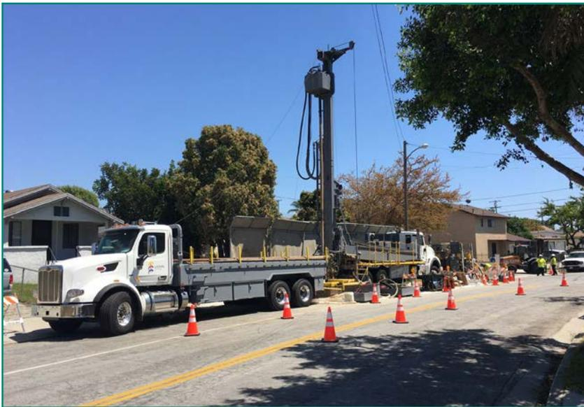
**Figura 4:** Instalación de LW-12 en mayo. Este pozo de monitoreo se instaló para verificar los contaminantes en el acuífero más profundo (225 a 245 pies debajo de la superficie del suelo).
