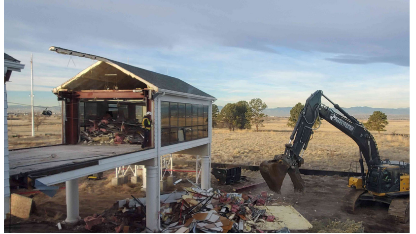
▲ La renovación del sitio incluyó mejoras al edificio y las áreas de estacionamiento.
