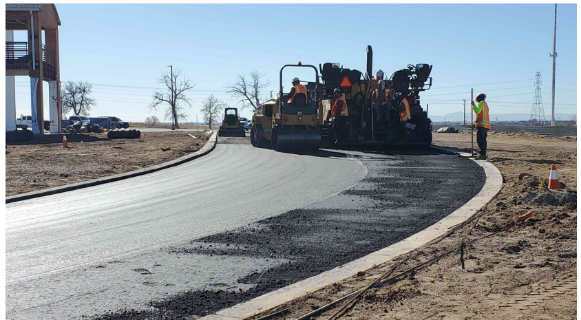
▲ Las mejoras en el flujo de tráfico aumentan la seguridad del sitio para empleados y visitantes.
