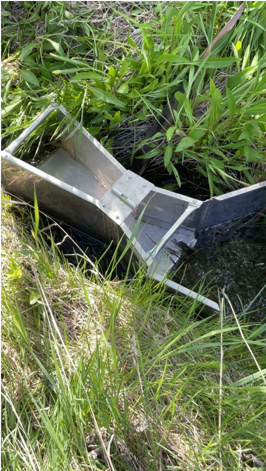
Photo # 167 ST016 Flume
