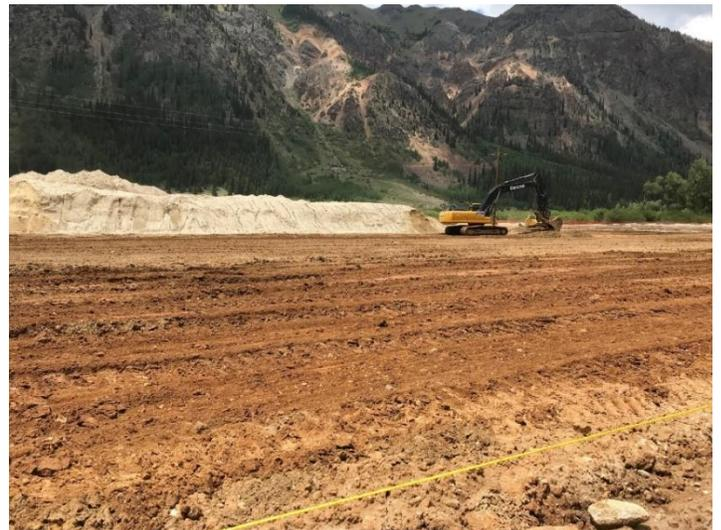
*El fango de la planta provisional de tratamiento de aguas se mezcla con los relaves de Kittimac (fondo) en la planta provisional de manejo de fango.*
