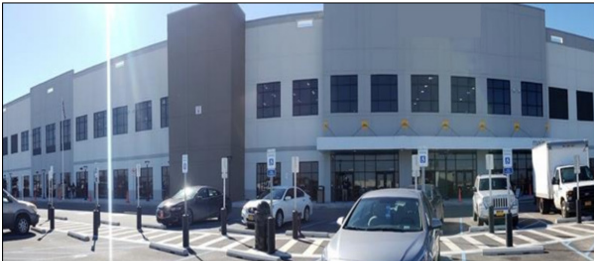
4: Ejemplo de un centro logístico después de que su construcción se haya realizado. Fuente: IDA.
