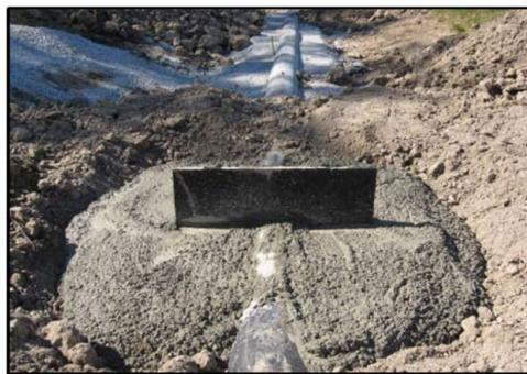
6 CONCRETE BACKFILL AROUND ANTI-SEEP COLLARS
