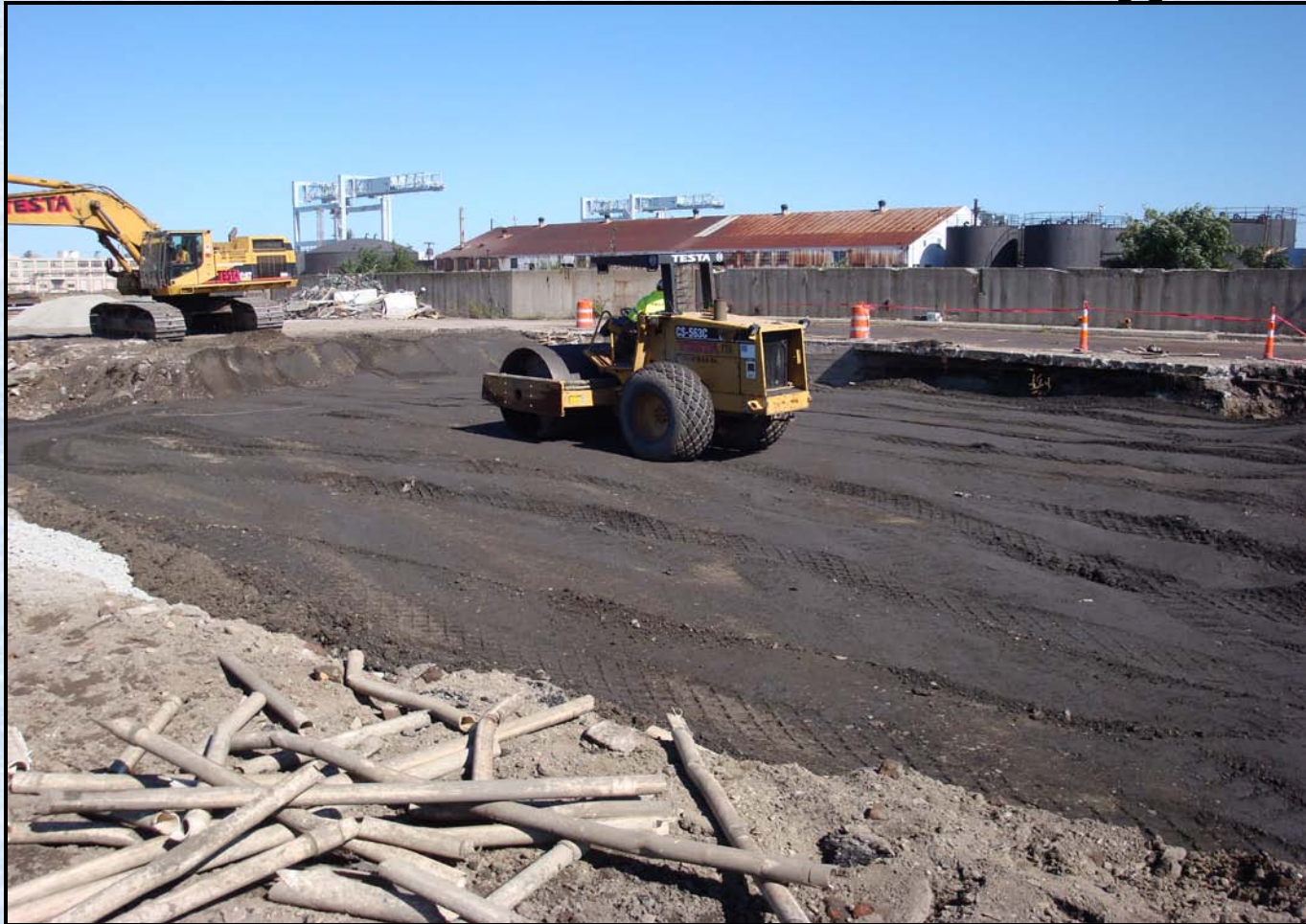
Fill Compaction
