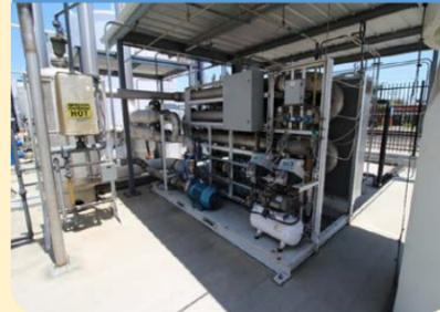
**Separador de Aire:** Remueve VOCs añadiendo air para que los VOCs se evaporen
