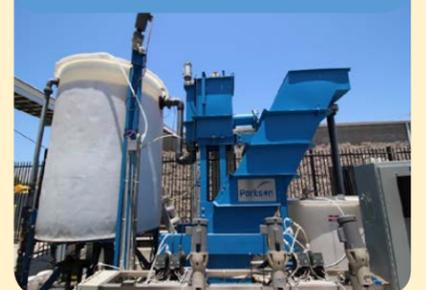
**Filtro Prensa:** Comprime los sólidos para disposición
